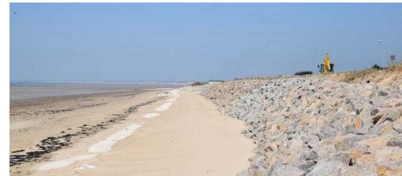
16 000 tonnes de rochers posés à Gouville-sur-Mer en mai 2020.
