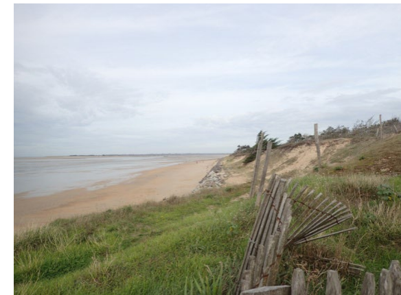
Canivelles implantées pour fixer la dune
