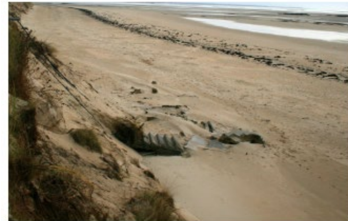
Près de Saint-Germain-sur-Ay, exemple d'une maison tombée à l'eau en 2015.
