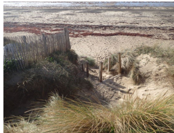
Canivelles implantées pour fixer la dune
