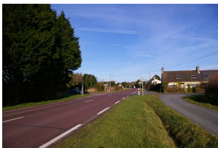
La végétation le long de la RD marque le paysage.
